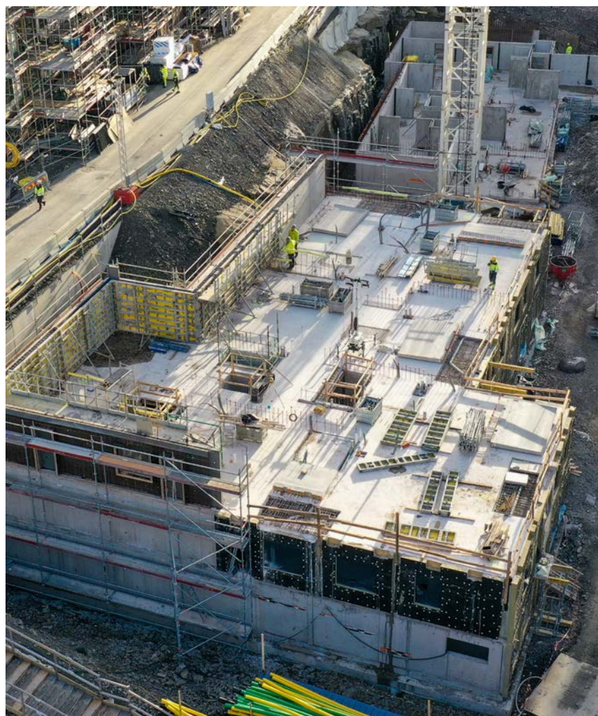
Bygget är igång i Östra Källtorp.
