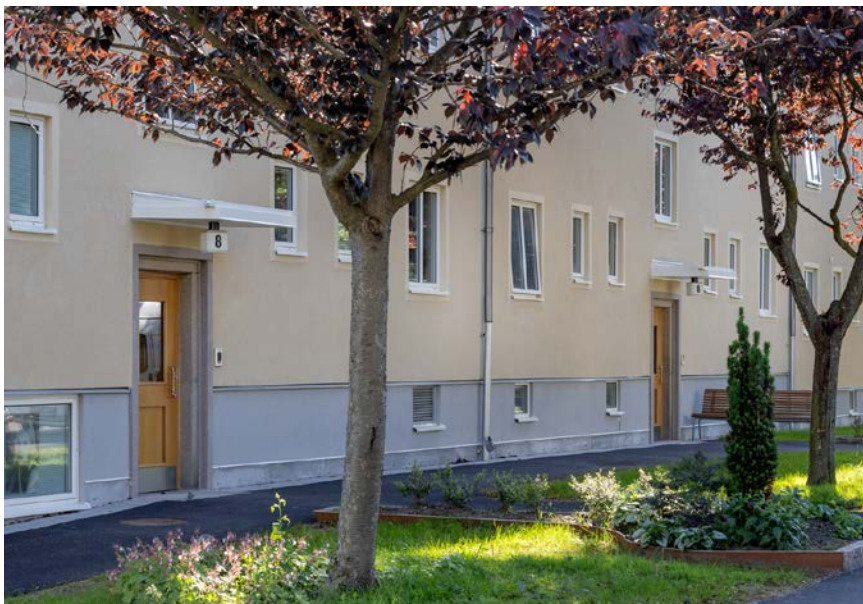
På Byalagsgatan i Kyrkbyn har vi klimatberäknat en fasadrenovering.
