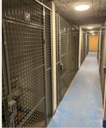
Träväggar byts till säkerhetsklassade gallerväggar i många lägenhetsförråd.
