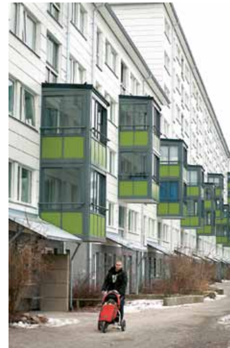
Det har satts nya balkonger på fasaden i de lägenheter där infällda balkonger har byggts om.
