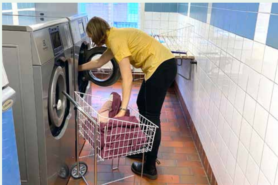
Maskinen väger tvätten du lagt in och doserar med exakt rätt mängd tvättmedel. Inget spill och mindre tvättmedelsrester som sköljs ut. Bra för både tvättstuga och miljö.
