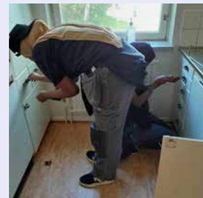
Inför att huset i Kortedala ska renoveras har hatthyllor, beslag och krokliker med mera tagits tillvara för återbruk.
