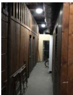
Bild ovan: Så här såg det ut före ombyggnad. Tolv vindslägenheter står nu klara och nya vindsförråd finns ovanför dem.
