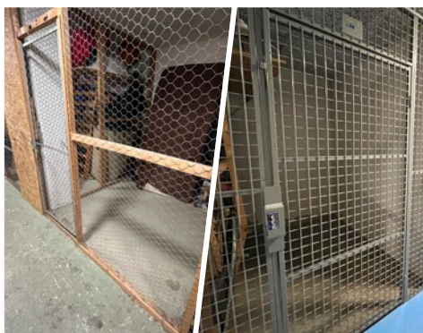
Källarförråd – före och efter inbrottssäkringen.
